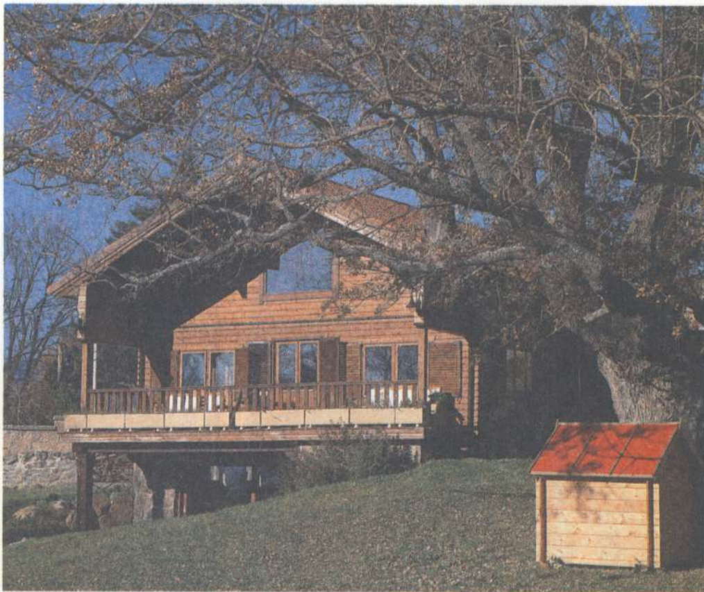
CON PIEDRA. Asentada sobre una base de hormigón, esta casa de madera cuenta con una cubierta de teja y un sólido zócalo de piedra local.
