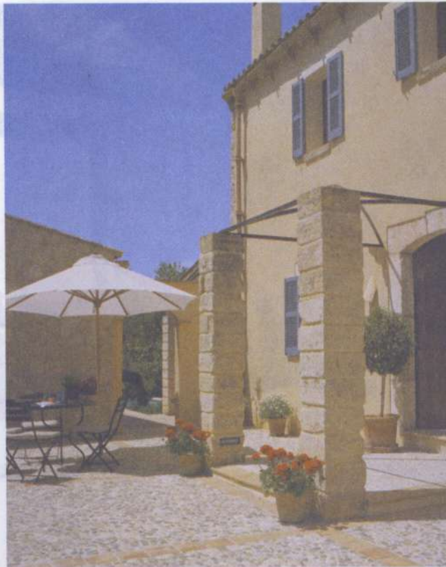
MATERIALES. Edificar un porche con columnas de piedra de la región (en este caso, marés mallorquín) es una forma de construir de forma sostenible.
