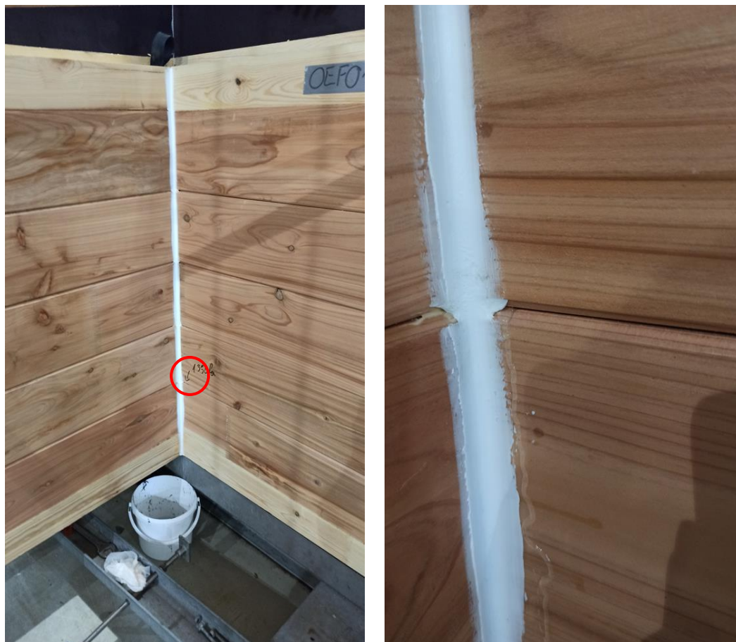
Figura 7 – Identificação dos pontos onde se verificou a perda de estanquidade do provete.
